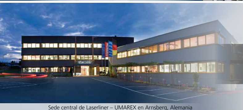
Sede central de Laserliner – UMAREX en Arnberg, Alemania
